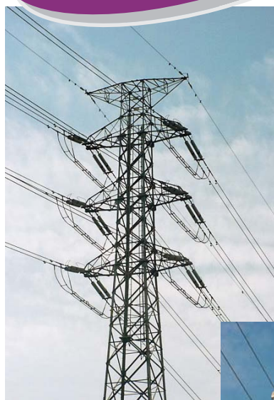
送電線は高い電圧の電気を流しておりますので、電線を支える支持物は、主に鉄塔が使われています。
