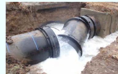
水道管φ2400mmの抜け出し被害
