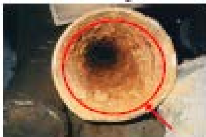
—錆が付着した水道管の内面—
