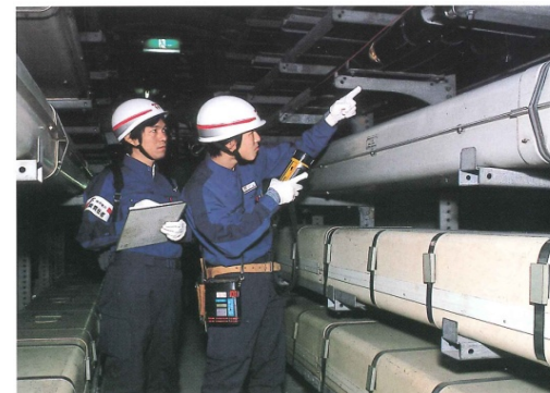
—道路下での点検状況—
