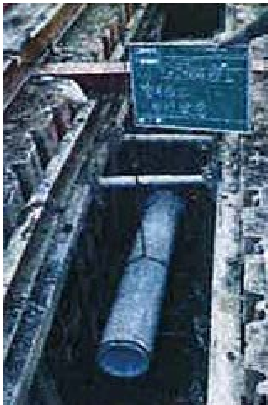
管路新設状況写真
