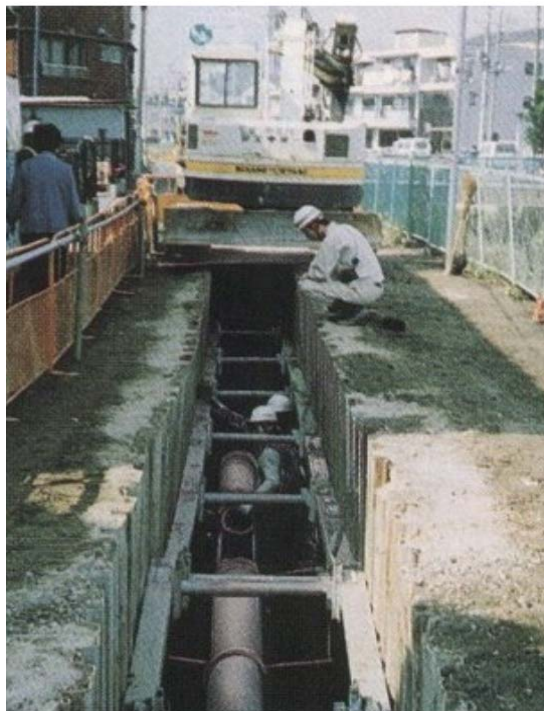
管路取替状況写真
