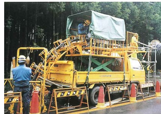
—道路上でのケーブル引入作業—
