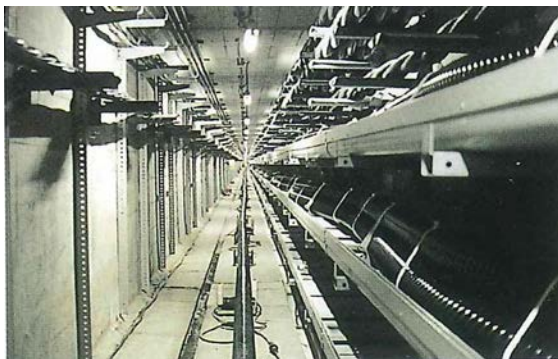
—道路下での設備取替作業—
